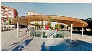
uzcanga arquitectos _ cubierta de biblioteca de iun
