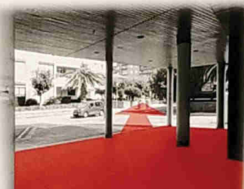
Vista hacia Plaza J.A. Agirre desde porche de viviendas
