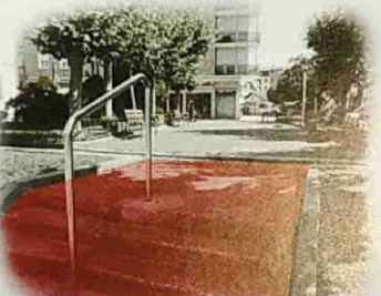
Barreras arquitectónicas (escaleras) para acceso al parque
