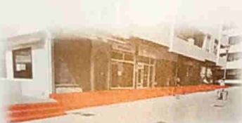
Fachada locales al sur
