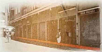
Fachada locales al norte
